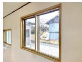
内窓の設置事例
