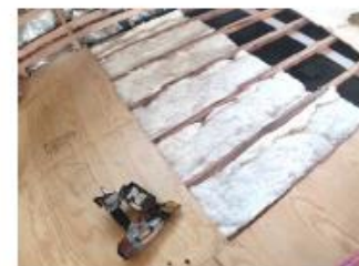
断熱材の設置事例
